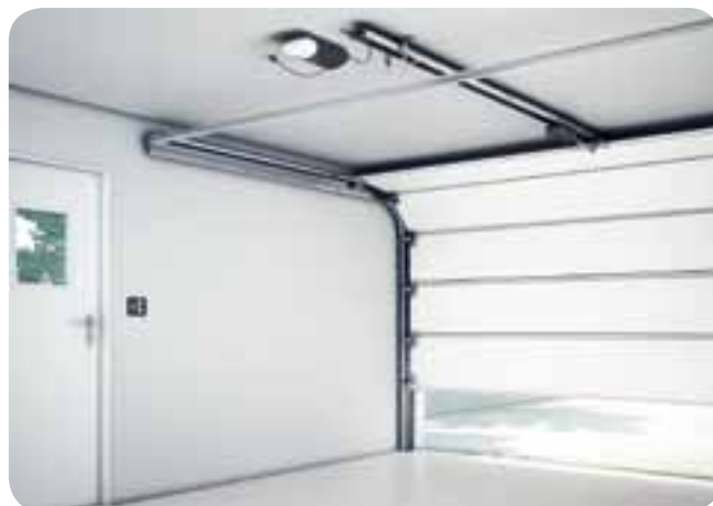
Montage an der Decke
